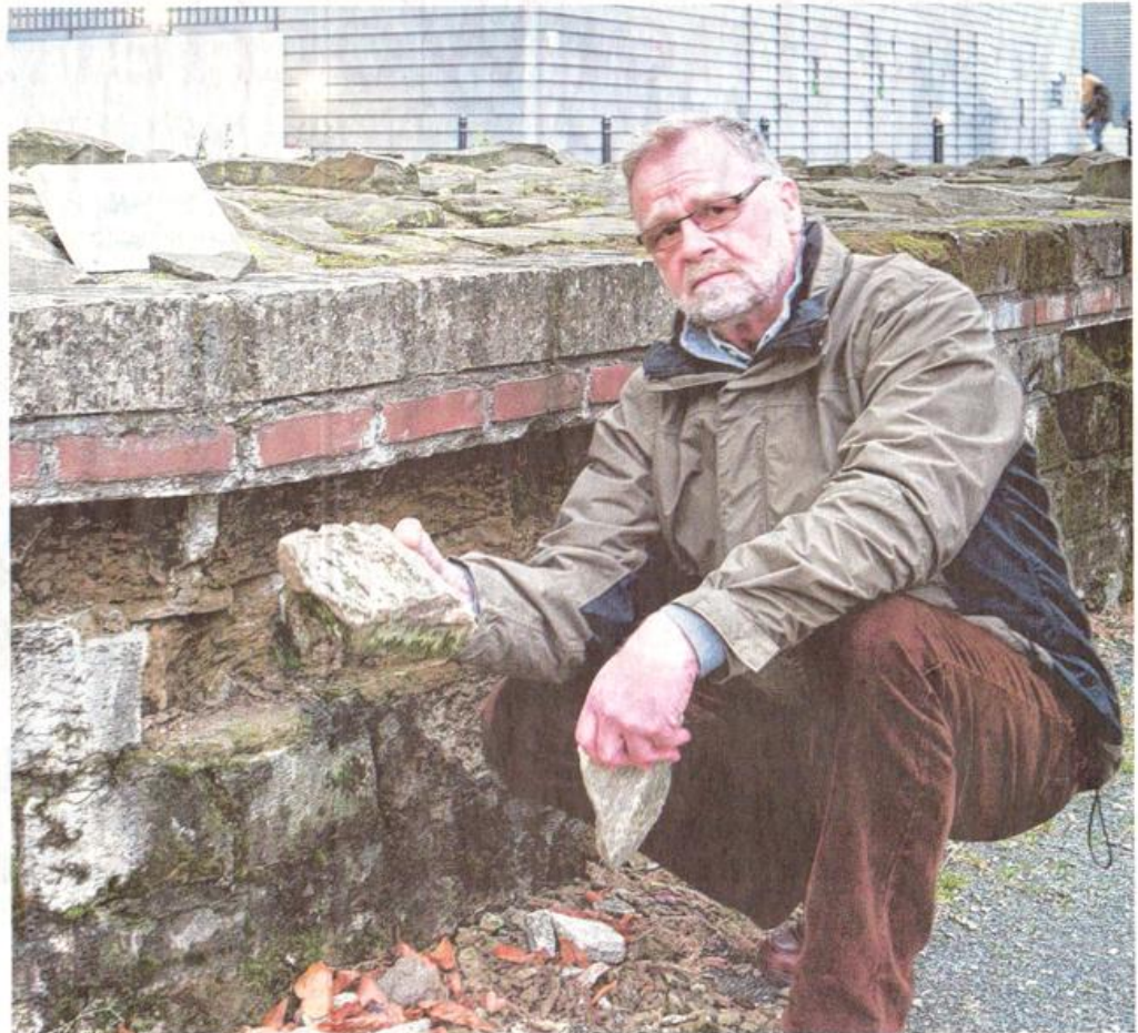
Im Mauerwerk klaffen große Lücken: Thomas-Georg Tremblau, Vorsitzender des Fördervereins Historischer Park Deutz, sorgt sich um den Erhalt des Osttores des römischen Kastells Divitia. Foto: König
