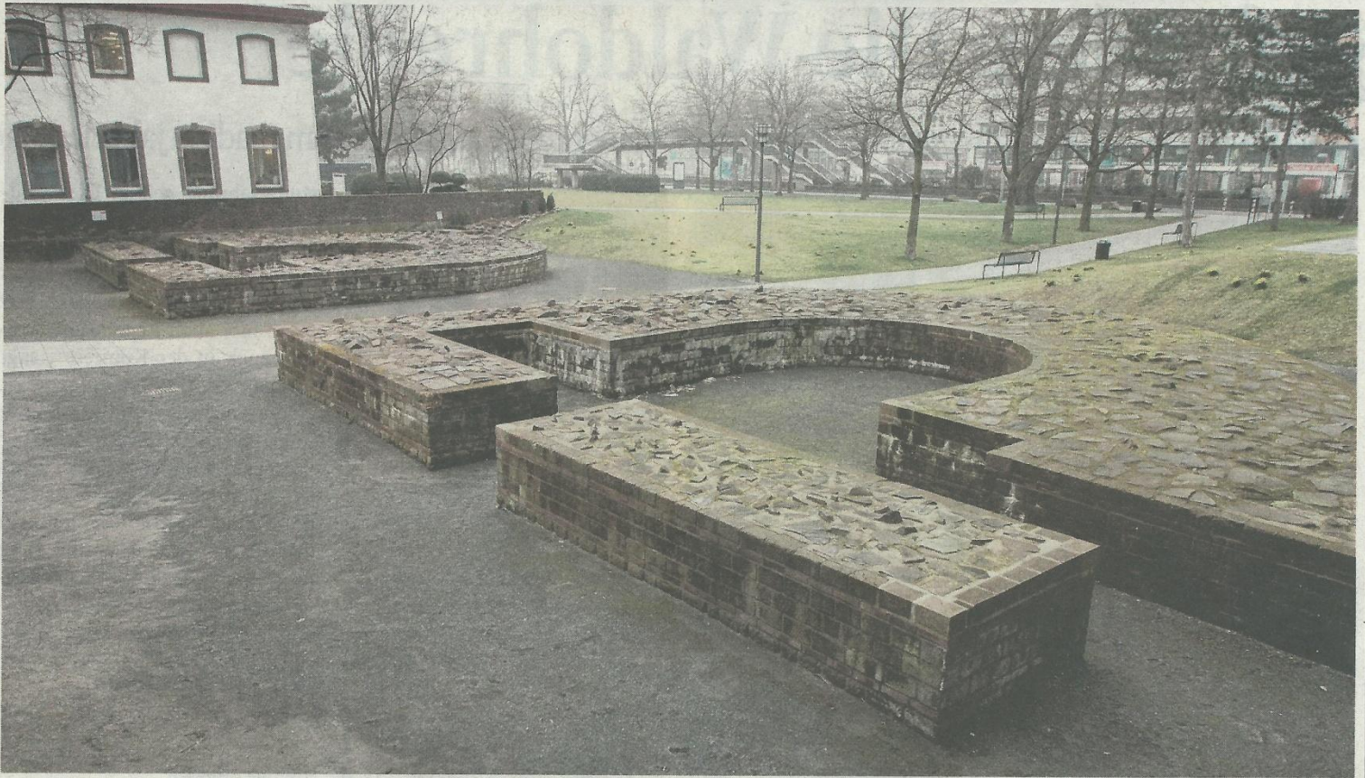
Regen und Grundwasser setzen den Überresten des römischen Osttors in Deutz zu.
